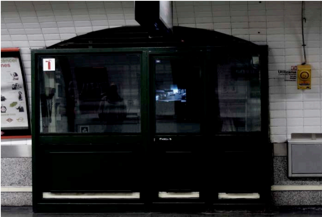
Imagen de la caseta de control, en cuyo interior está situada la pantalla que muestra "Alarma"
